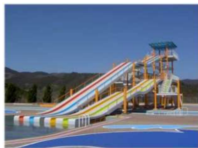
運動公園スライダー全面塗装
