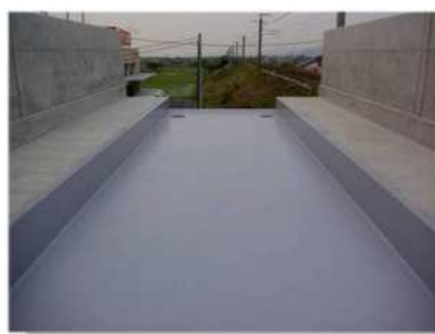
JR鉄道コンクリート橋 床版防水
