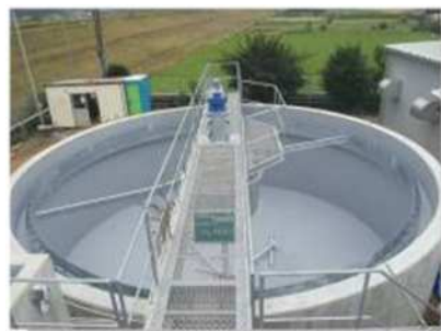
JA汚水処理施設防食・防水処理
