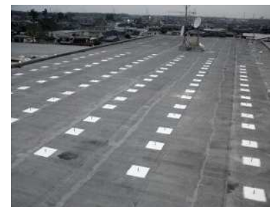
つくば市太陽光発電接着基礎
