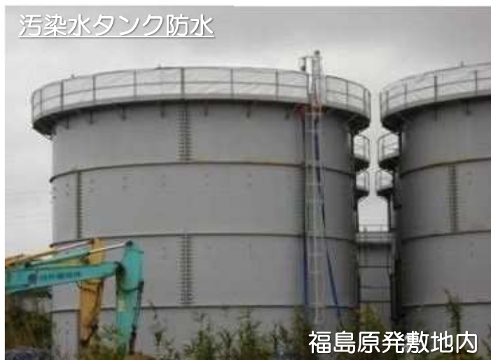
SCRAMSEAL-100による 接合部の止水
